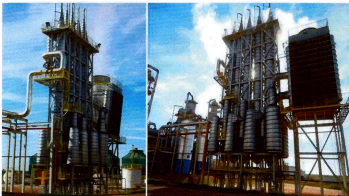
Figura 2.8 – Sistema de evaporação de vinhaça. Fonte: Dados de pesquisa, 2013.
